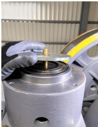
⑧コイルケースの4本ボルトを外して、コイルケースとブレーキコイルを外して下さい。
