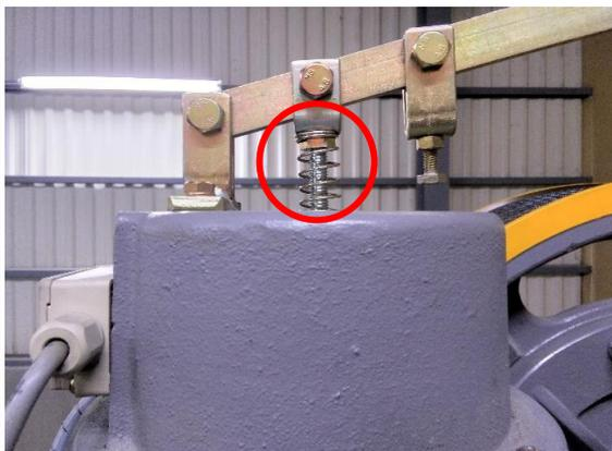
㉑コイルスプリング取外しと対策の押しボルト交換後は、改善完了済シールを、ブレーキコイルのコイルケース蓋上部又は側面部に貼付けて下さい。
