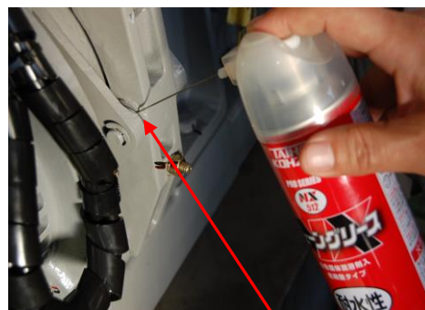
写真 2 : ブレーキシューピン部
