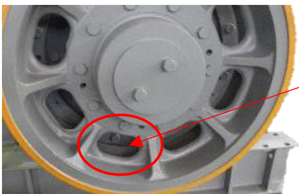
【写真3-7-③】ギヤケース（シーブ側）__ベース取付部
