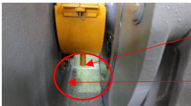
【写真3-7-①】 ギヤケース入力軸付近および油飛散防止カバー下部
