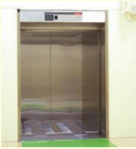
フロアタイプに、空気清浄システムを採用。かが室内部をクリーン仕様に仕上げています。精密機器や医療施設など、厳しい清浄条件が要求される場所で、大型荷物を台車ごと運搬できます。
